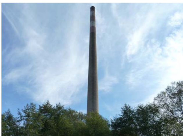
Foto 1: Pohled na komín ze severozápadu
