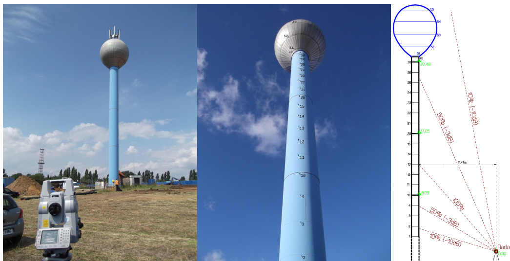
Obr. 6 Vodojem, spoje sekcí a prstenců sloupu, měřický náčrt
